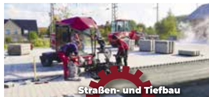
Straßen- und Tiefbau
