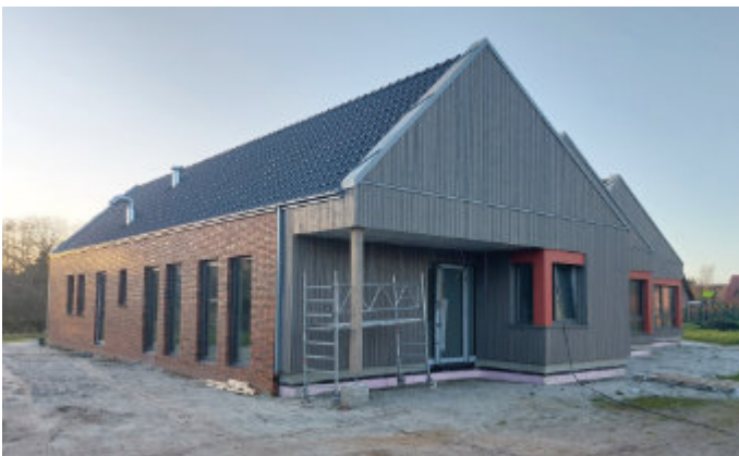
Kindergarten Warsingsfehn-West kurz vor der Fertigstellung.
